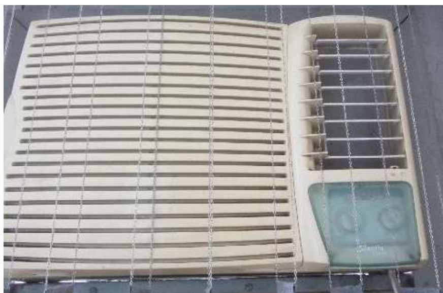
Figura 24 - AC 10000 btus - ADMINISTRAÇÃO CEASA MARINGÁ
