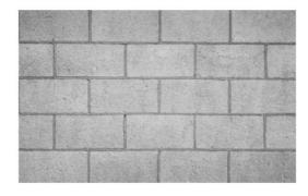
6.2.4.1. Mureta em alvenaria de bloco vazado de concreto aparente (19x19x39cm), com argamassa traço 1:2:8 (cimento, cal e areia):
