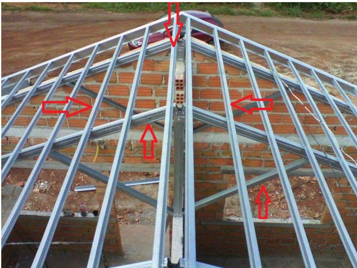
**Foto 5- Sistema de estrutura metálica composto pela Trama de aço e também tesoura metálica.**
