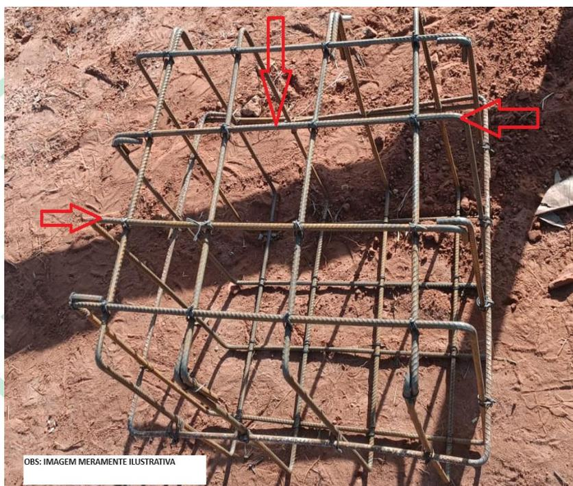
**Foto 3- Bloco de Coroamento de concreto armado**
