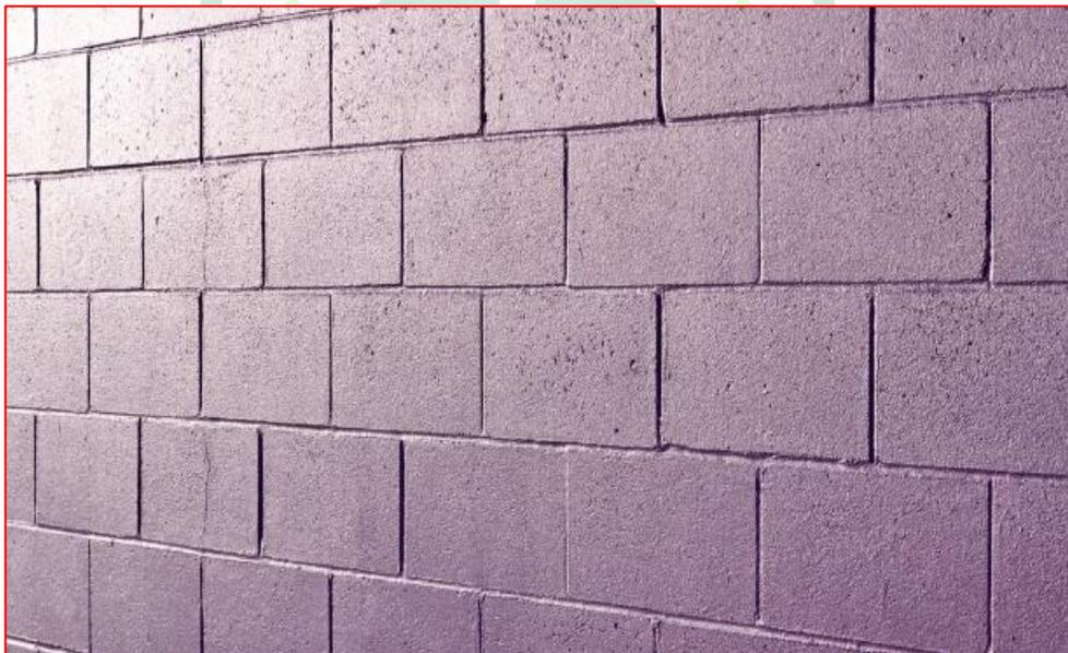
Figura 106 - Alvenaria de Bloco de Concreto com revestimento de Resina Acrílica - Fonte: Google
