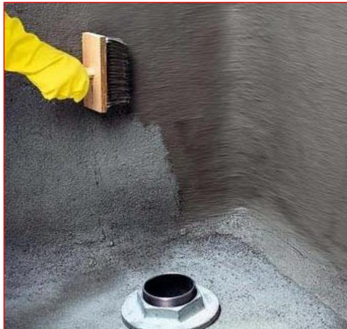
Figura 353 - Aplicação de impermeabilização semi-flexível - Argamassa Polimérica - Fonte: Google
