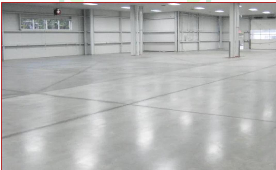
Figura 25 - Acabamento polido em cimento queimado com aplicação de resina - Fonte: Google
