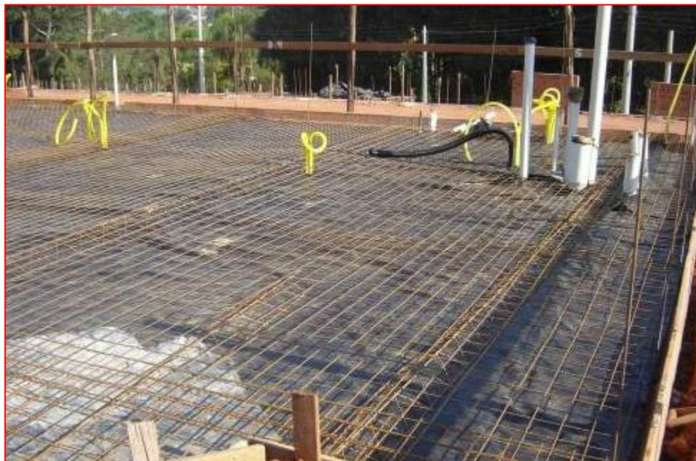
Figura 103 - Lona plástica separadora e armadura de piso - Fonte: Google
