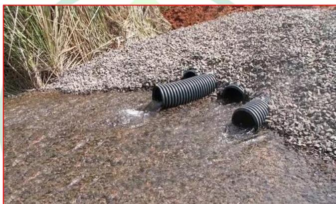
Figura 54 - Tubo corrugado PEAD para auxílio de drenagem - Fonte: Google
