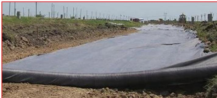
Figura 376 - Manta geotêxtil para filtragem de água - Fonte: Google
