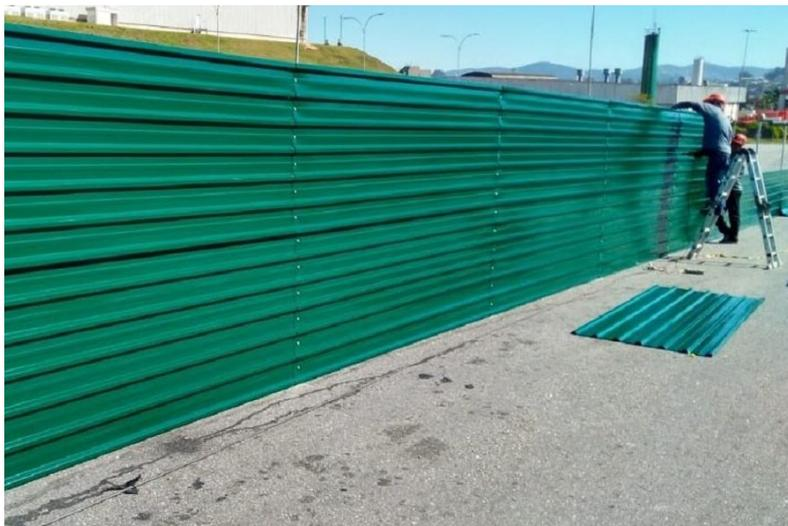
Figura 247 - Tapume em telha metálica trapezoidal - Fonte: Google.
