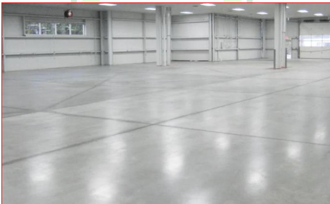
Figura 262 - Acabamento polido em cimento queimado com aplicação de resina - Fonte: Google
