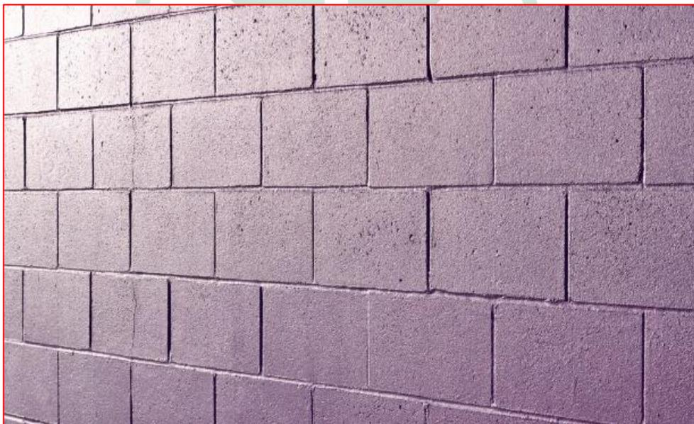
Figura 264 - Alvenaria de Bloco de Concreto com revestimento de Resina Acrílica - Fonte: Google
