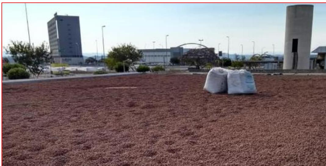
Figura 56 - Argila expandida em telhado - Fonte: Google
