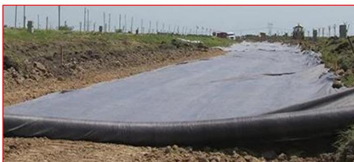
Figura 135 - Manta geotêxtil para filtragem de água - Fonte: Google
