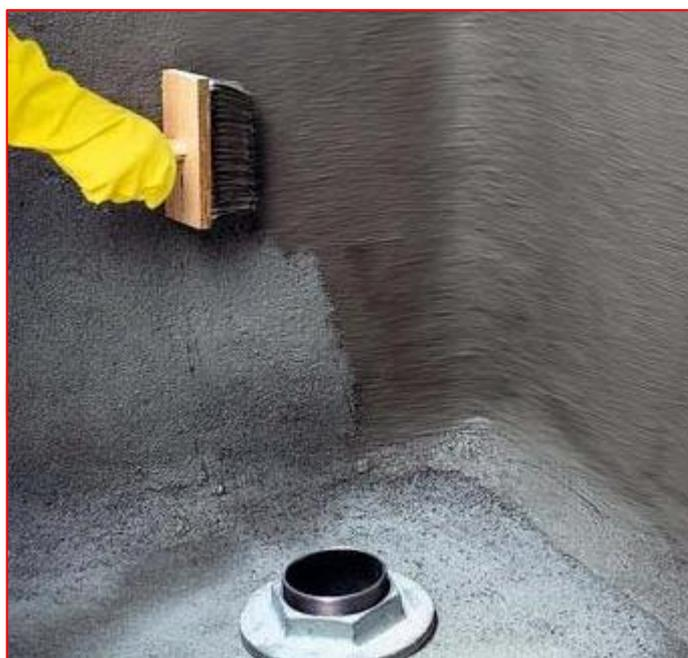
Figura 111 - Aplicação de impermeabilização semi-flexível - Argamassa Polimérica - Fonte: Google
