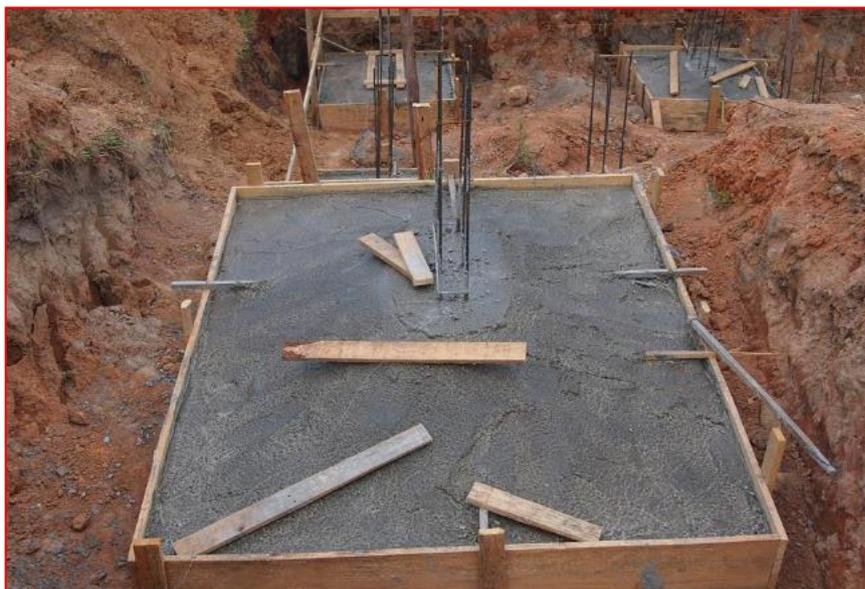
Figura 337 - Sapatas concretadas, com formas de madeira e armação. - Fonte: Google
