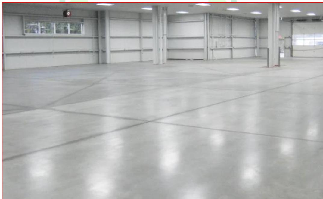
Figura 184 - Acabamento polido em cimento queimado com aplicação de resina - Fonte: Google
