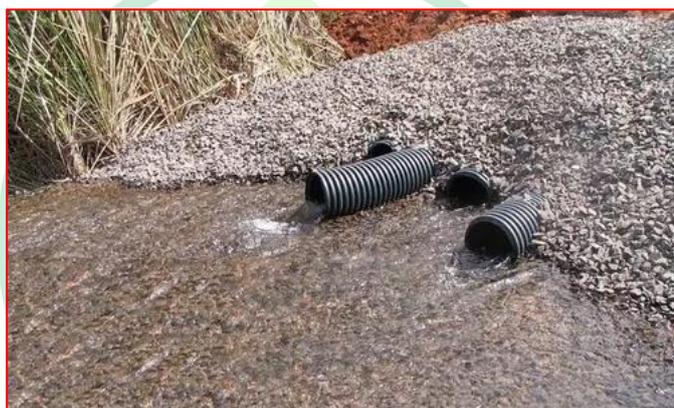
Figura 212 - Tubo corrugado PEAD para auxílio de drenagem - Fonte: Google
