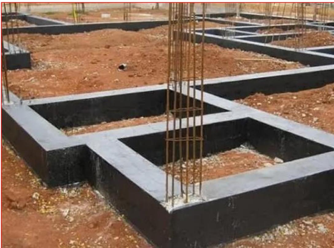
Figura 176 - Impermeabilização com emulsão asfáltica em Viga Baldrame - Fonte: Google.
