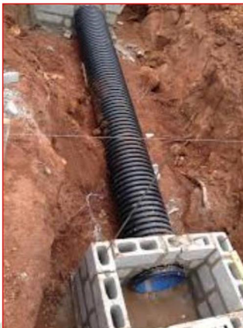
Figura 333 - Tubo PEAD corrugado de parede dupla - Fonte: Google
