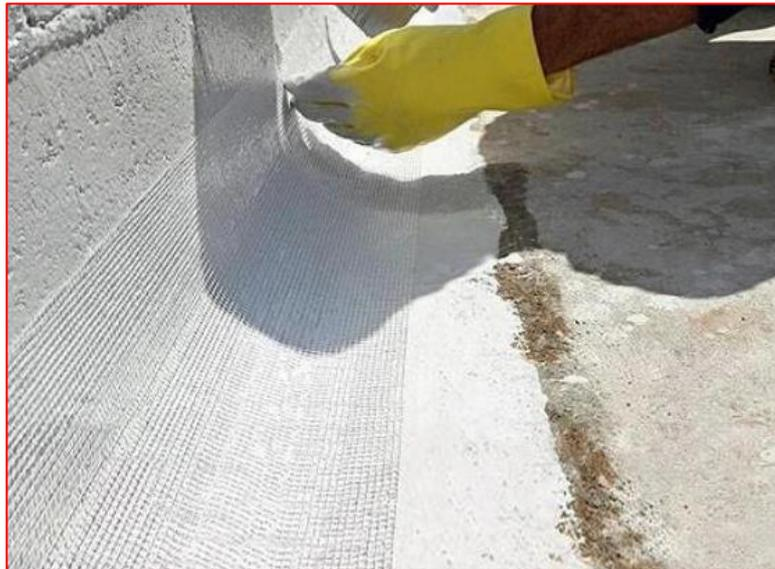
Figura 354 - Aplicação de impermeabilização flexível - Resina acrílica com véu estruturante - Fonte: Google
