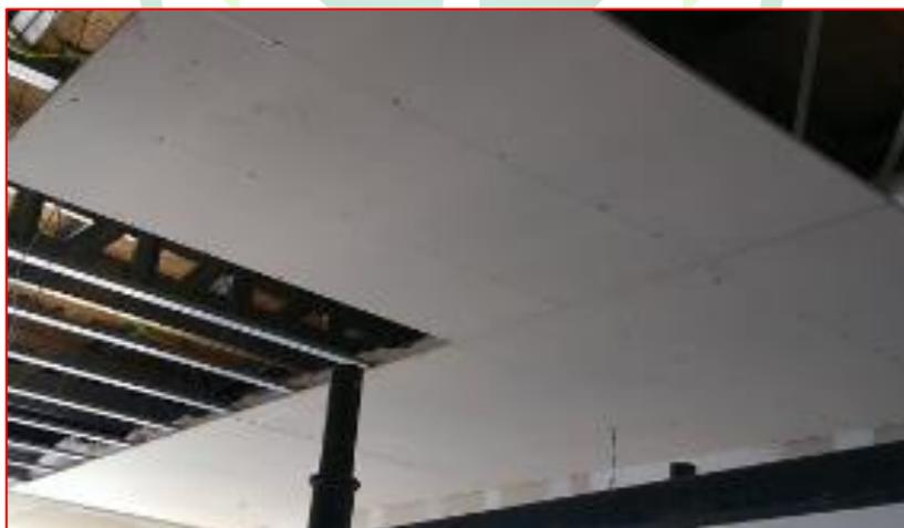
Figura 113 - Instalação de Forro em Placa cimentícia – Fonte: Google
