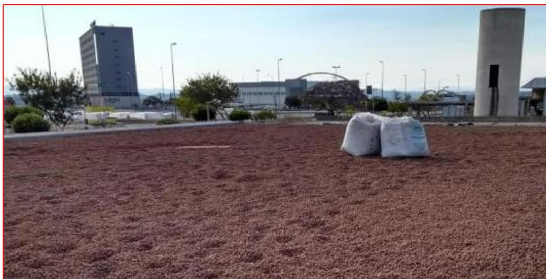
Figura 292 - Argila expandida em telhado - Fonte: Google
