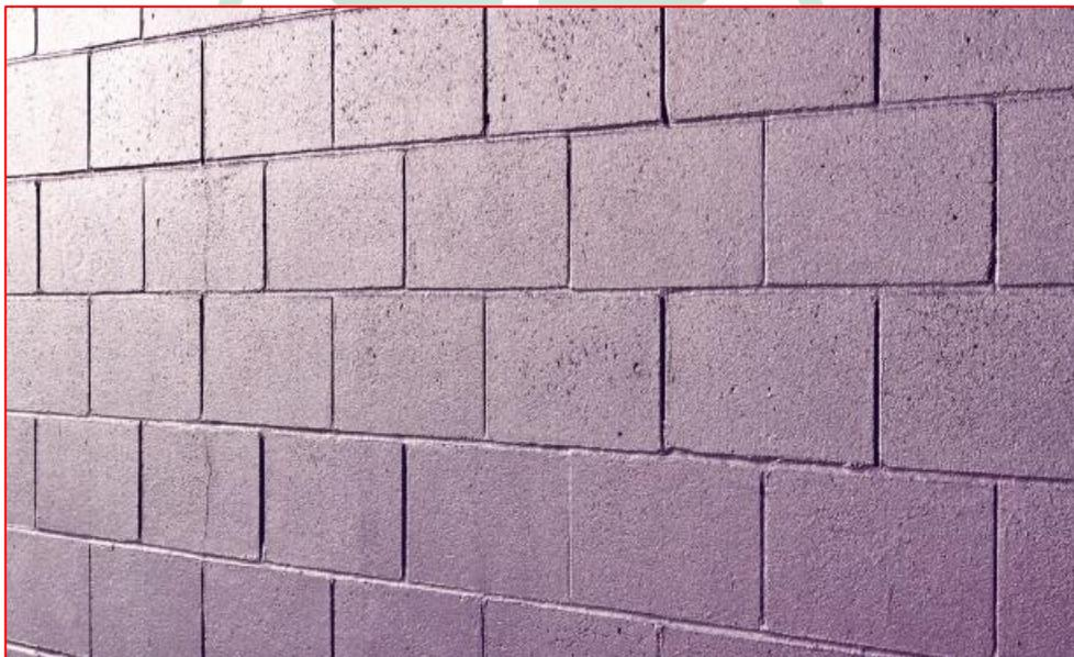
Figura 27 - Alvenaria de Bloco de Concreto com revestimento de Resina Acrílica - Fonte: Google
