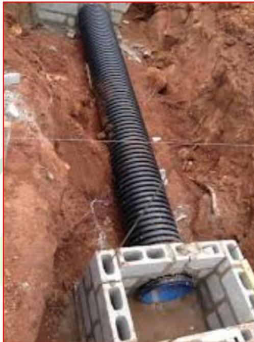
Figura 249 - Tubo PEAD corrugado de parede dupla - Fonte: Google
