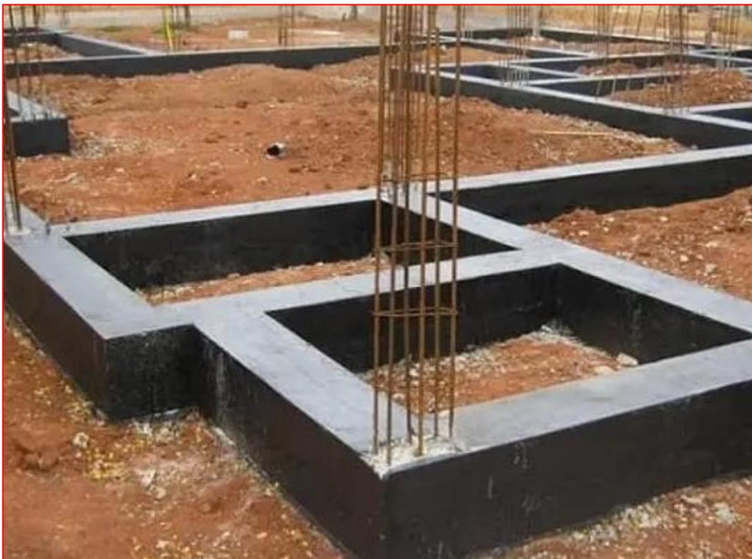
Figura 254 - Impermeabilização com emulsão asfáltica em Viga Baldrame - Fonte: Google.
