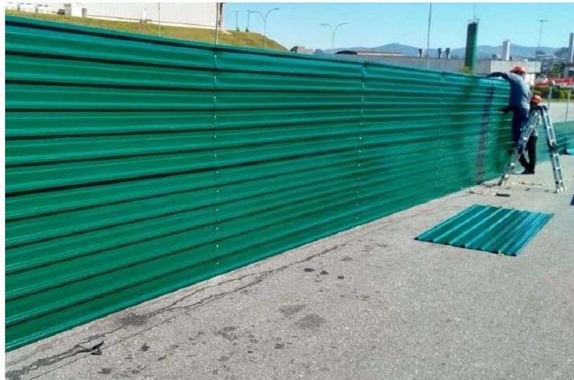
Figura 169 - Tapume em telha metálica trapezoidal - Fonte: Google.
