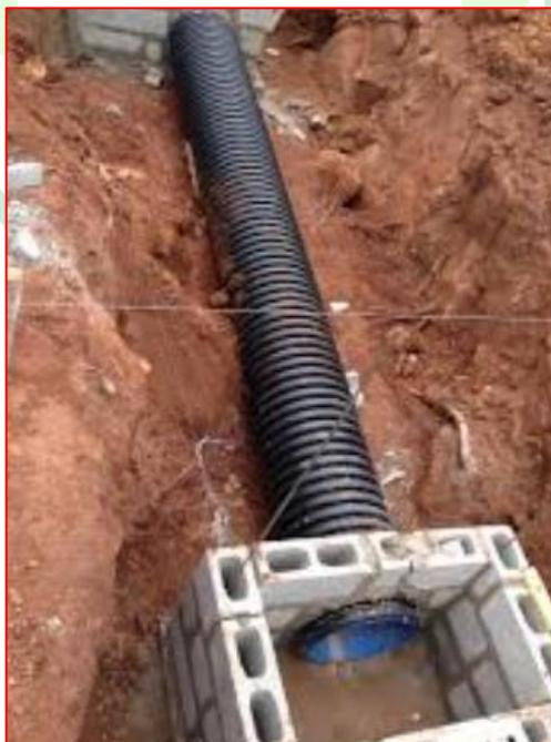
Figura 171 - Tubo PEAD corrugado de parede dupla - Fonte: Google
