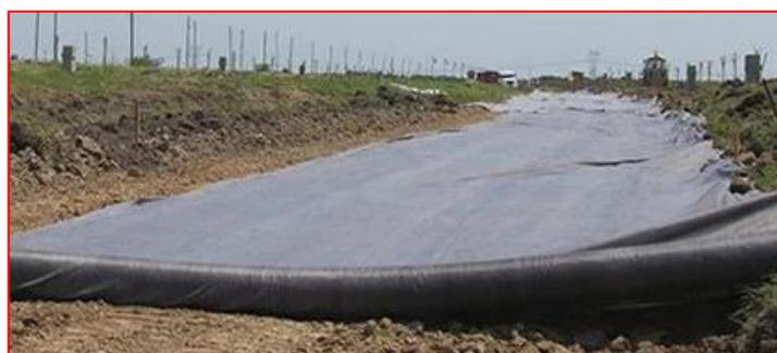
Figura 291 - Manta geotêxtil para filtragem de água - Fonte: Google
