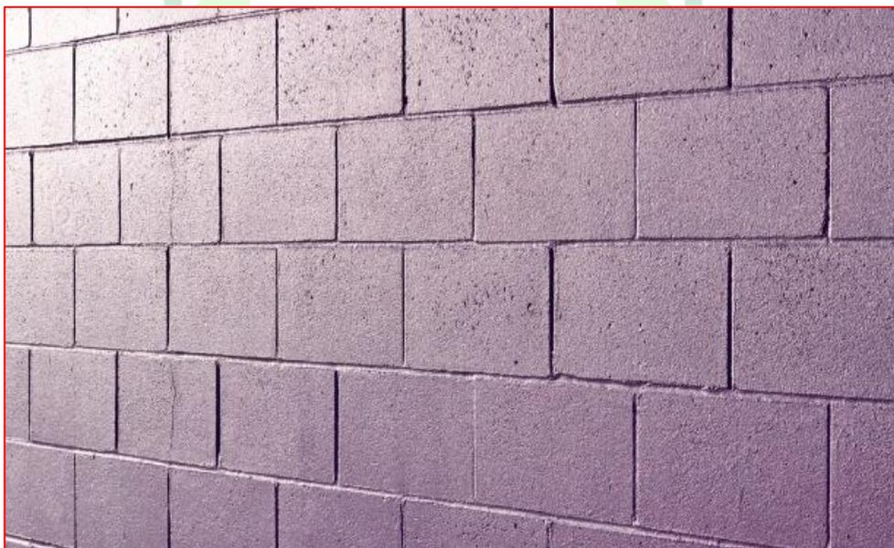
Figura 348 - Alvenaria de Bloco de Concreto com revestimento de Resina Acrílica - Fonte: Google
