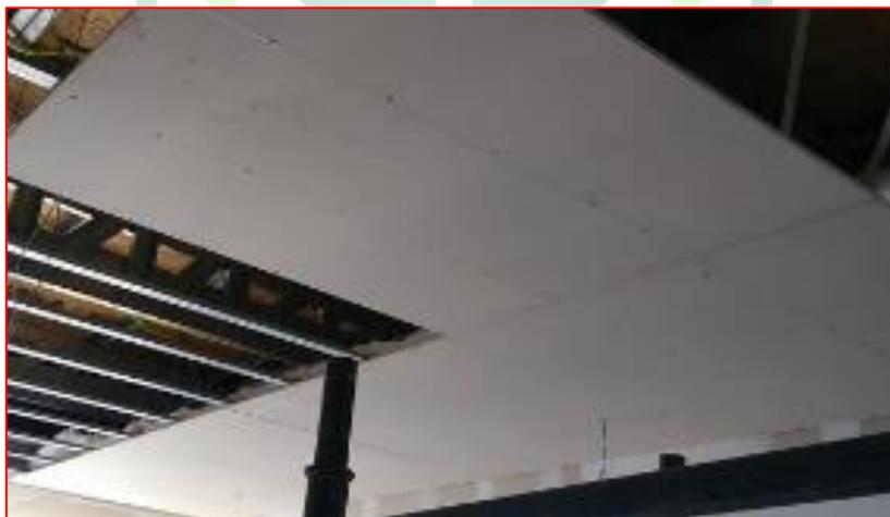
Figura 34 - Instalação de Forro em Placa cimentícia – Fonte: Google
