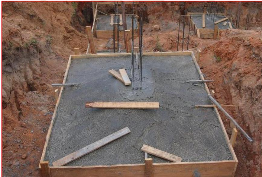
Figura 175 - Sapatas concretadas, com formas de madeira e armação. - Fonte: Google
