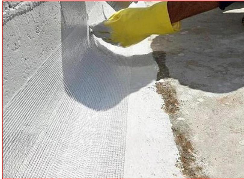
Figura 192 - Aplicação de impermeabilização flexível - Resina acrílica com véu estruturante - Fonte: Google
