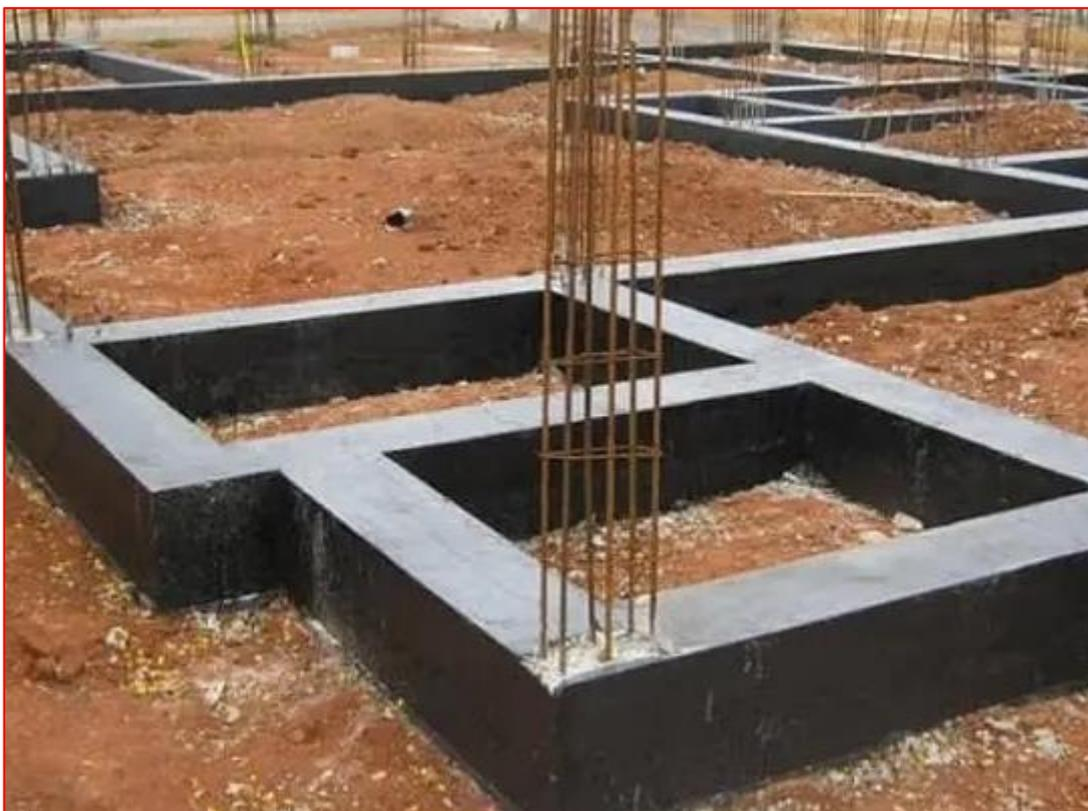
Figura 96 - Impermeabilização com emulsão asfáltica em Viga Baldrame - Fonte: Google.
