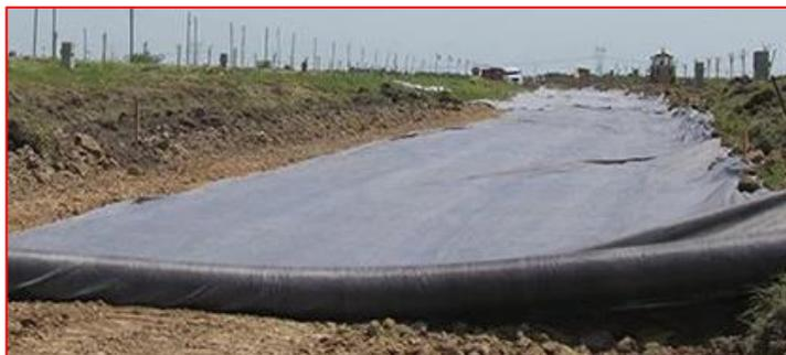
Figura 55 - Manta geotêxtil para filtragem de água - Fonte: Google
