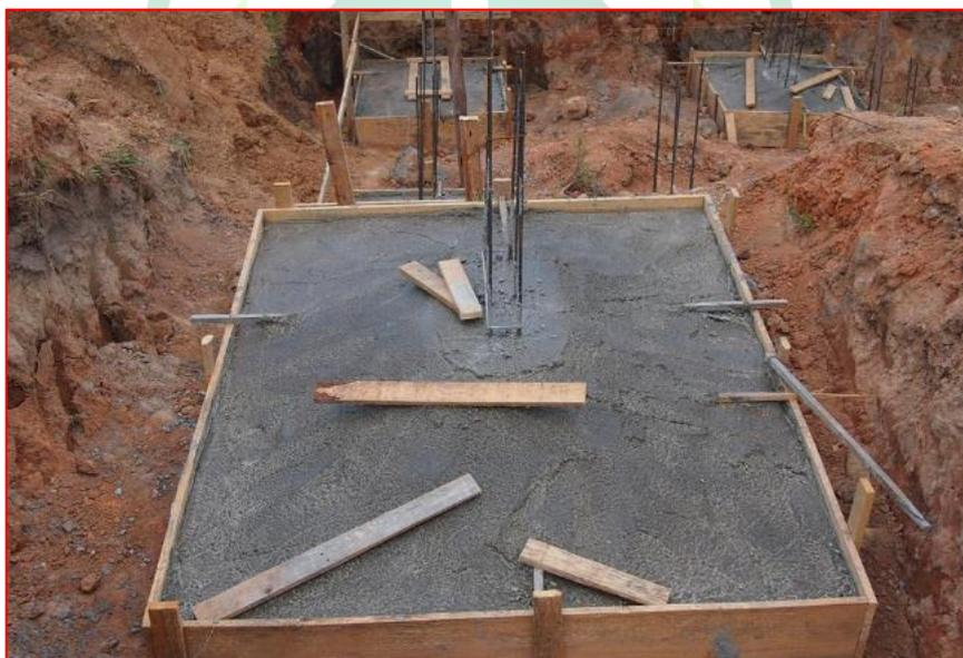
Figura 16 - Sapatas concretadas, com formas de madeira e armação. - Fonte: Google
