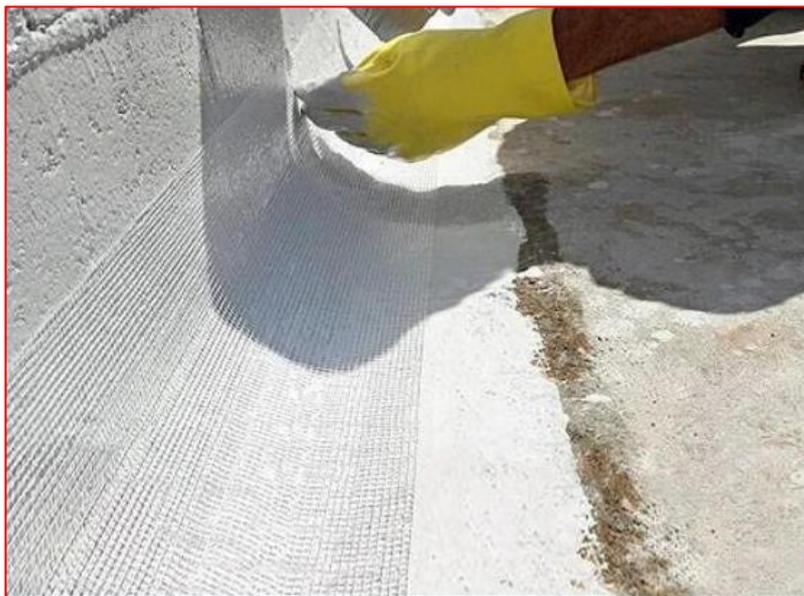
Figura 112 - Aplicação de impermeabilização flexível - Resina acrílica com véu estruturante - Fonte: Google
