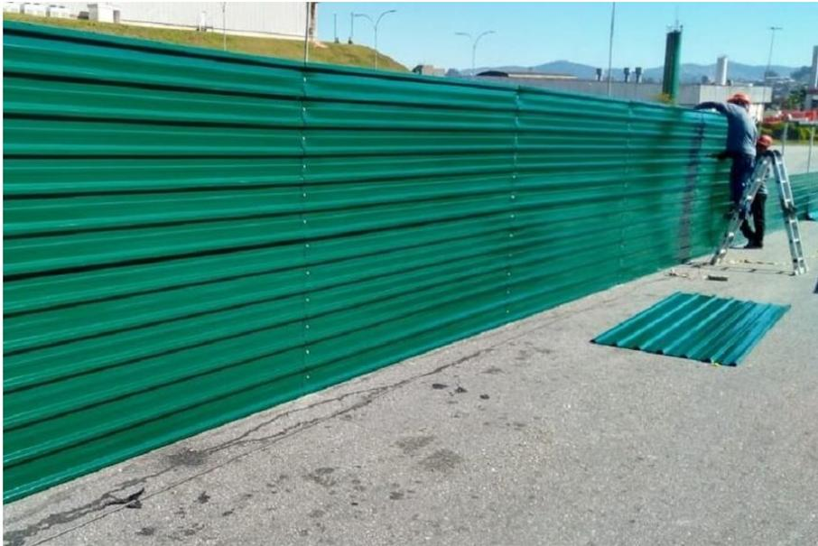
Figura 332 - Tapume em telha metálica trapezoidal - Fonte: Google.
