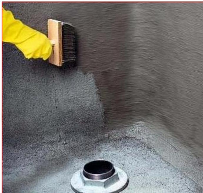
Figura 191 - Aplicação de impermeabilização semi-flexível - Argamassa Polimérica - Fonte: Google
