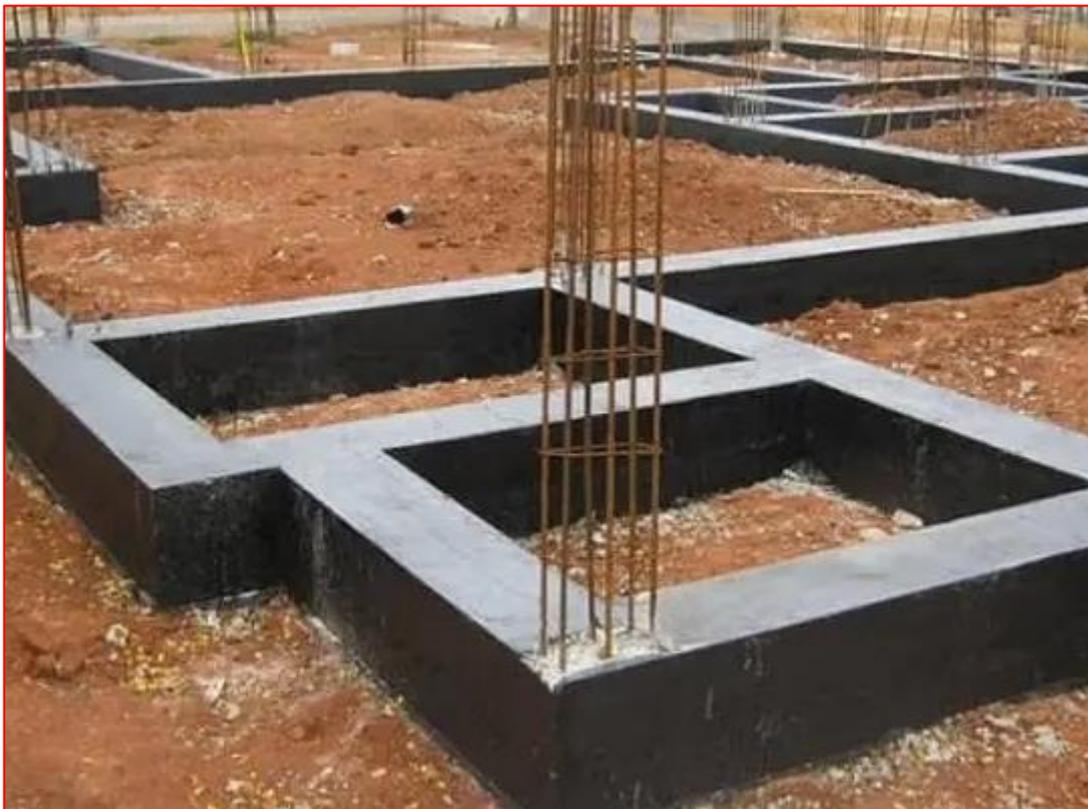
Figura 338 - Impermeabilização com emulsão asfáltica em Viga Baldrame - Fonte: Google.
