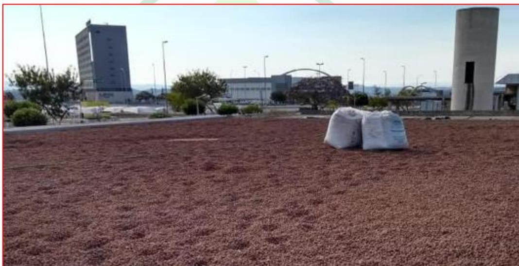
Figura 377 - Argila expandida em telhado - Fonte: Google
