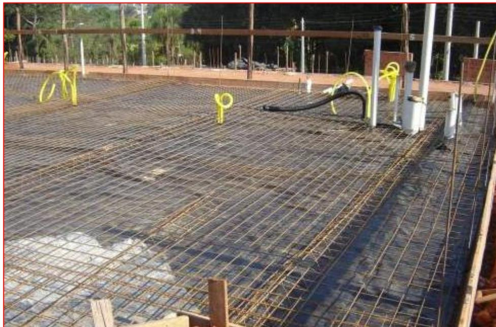
Figura 345 - Lona plástica separadora e armação de piso - Fonte: Google
