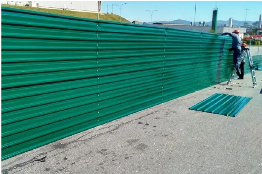
*Figura 90 - Tapume em telha metálica trapezoidal - Fonte: Google.*
