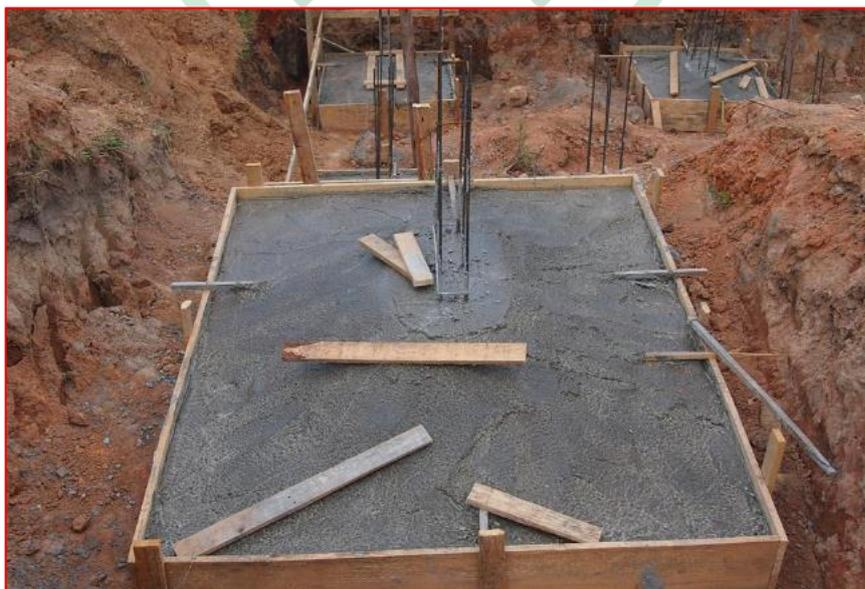
Figura 95 - Sapatas concretadas, com formas de madeira e armação. - Fonte: Google
