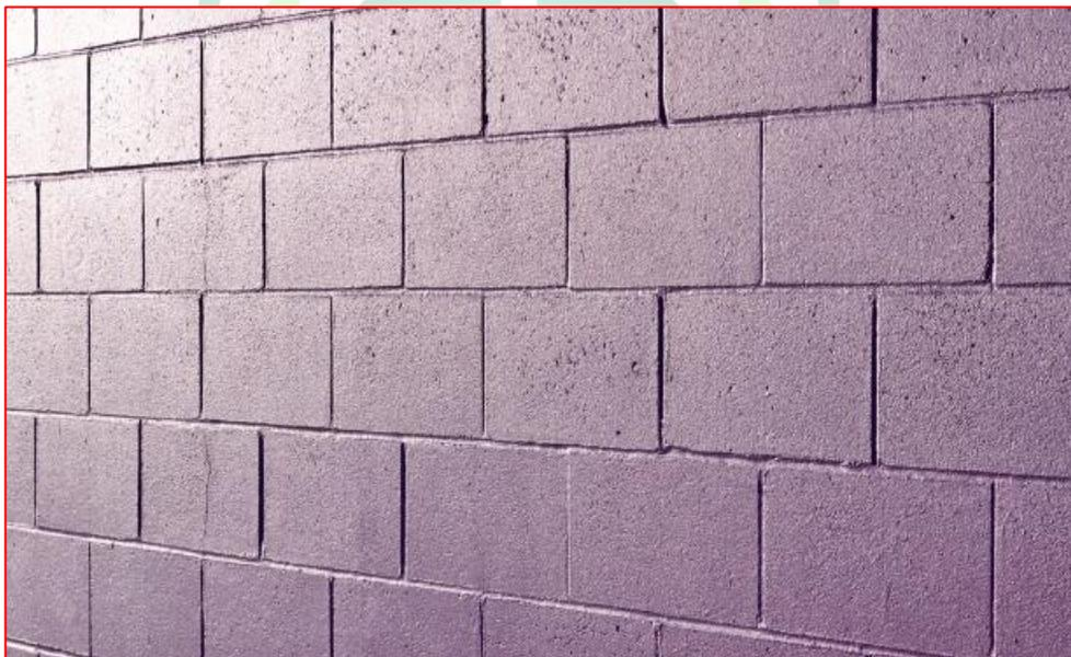
Figura 186 - Alvenaria de Bloco de Concreto com revestimento de Resina Acrílica - Fonte: Google
