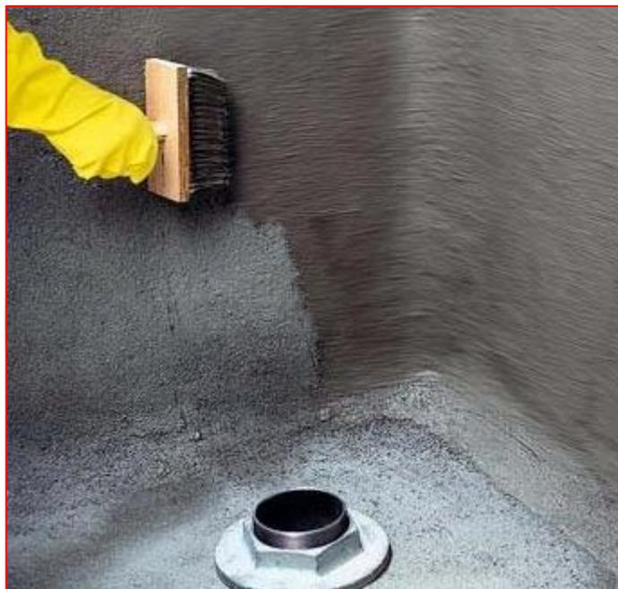
Figura 32 - Aplicação de impermeabilização semi-flexível - Argamassa Polimérica - Fonte: Google
