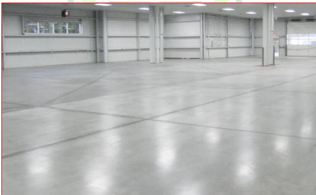
Figura 346 - Acabamento polido em cimento queimado com aplicação de resina - Fonte: Google
