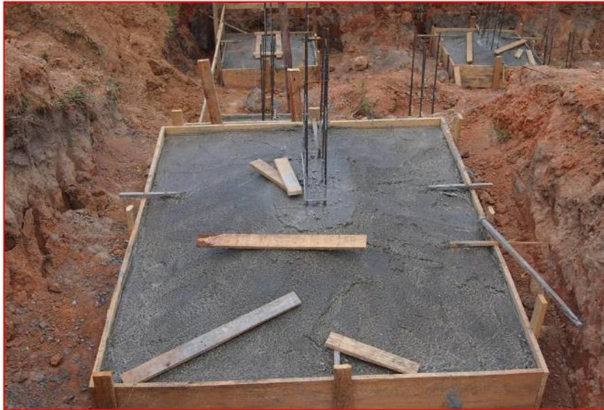
Figura 253 - Sapatas concretadas, com formas de madeira e armação. - Fonte: Google
