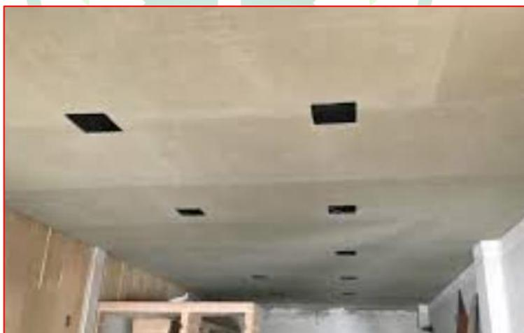
Figura 210 - Especificação final de placa cimentícia instalada - Fonte: Google
