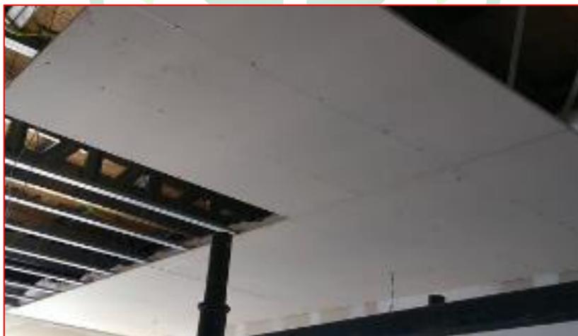
Figura 355 - Instalação de Forro em Placa cimentícia – Fonte: Google
