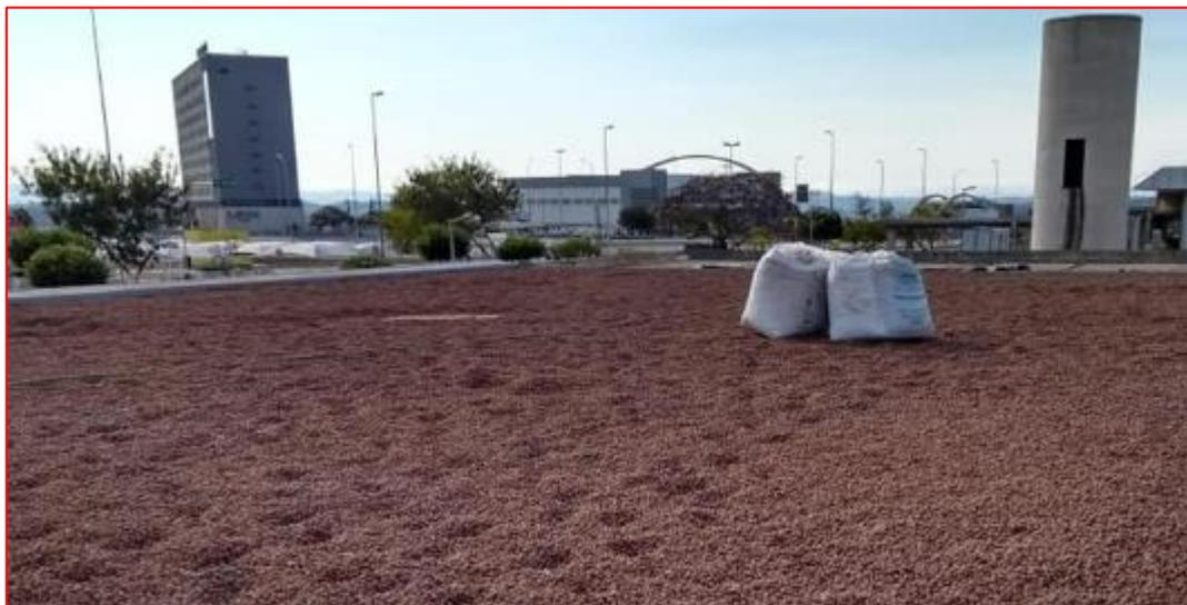
Figura 214 - Argila expandida em telhado - Fonte: Google
