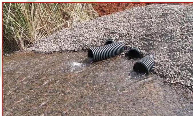
Figura 375 - Tubo corrugado PEAD para auxílio de drenagem - Fonte: Google
