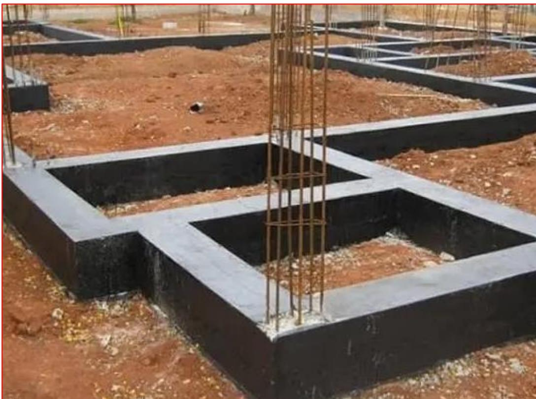
Figura 17 - Impermeabilização com emulsão asfáltica em Viga Baldrame - Fonte: Google.
