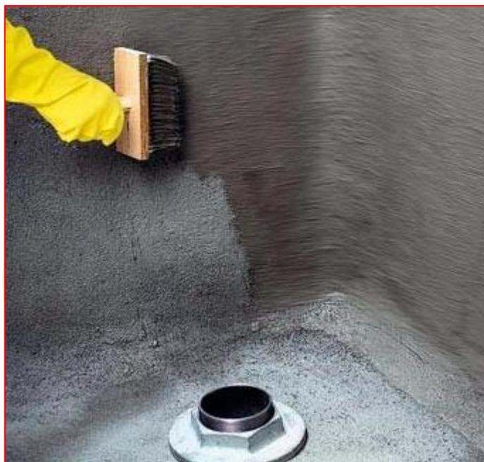
Figura 269 - Aplicação de impermeabilização semi-flexível - Argamassa Polimérica - Fonte: Google
