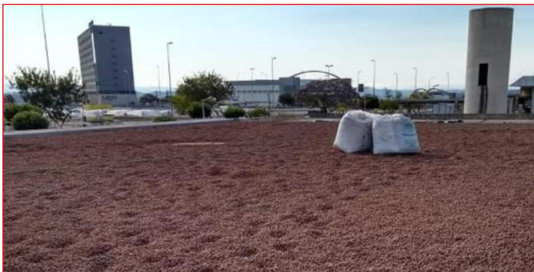
Figura 136 - Argila expandida em telhado - Fonte: Google
