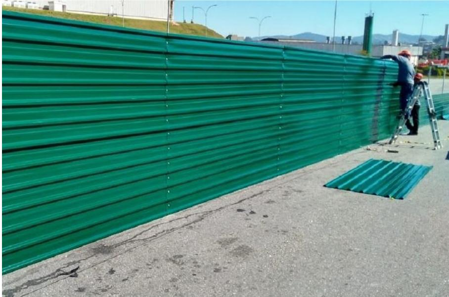
Figura 11 - Tapume em telha metálica trapezoidal - Fonte: Google.
