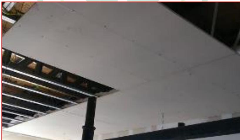
Figura 271 - Instalação de Forro em Placa cimentícia
