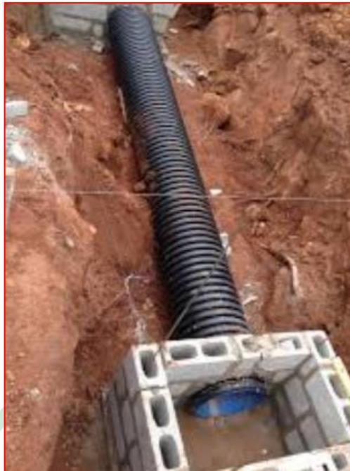
Figura 12 - Tubo PEAD corrugado de parede dupla - Fonte: Google
