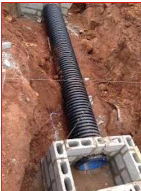
*Figura 91 - Tubo PEAD corrugado de parede dupla - Fonte: Google*
