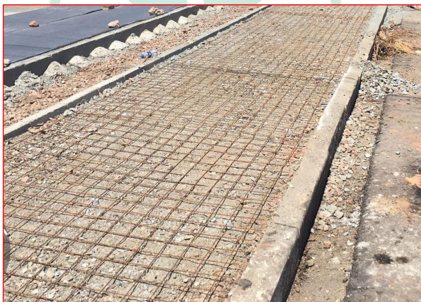
Figura 7 - Instalação de ferragem - Fonte: CEASA/PR.
