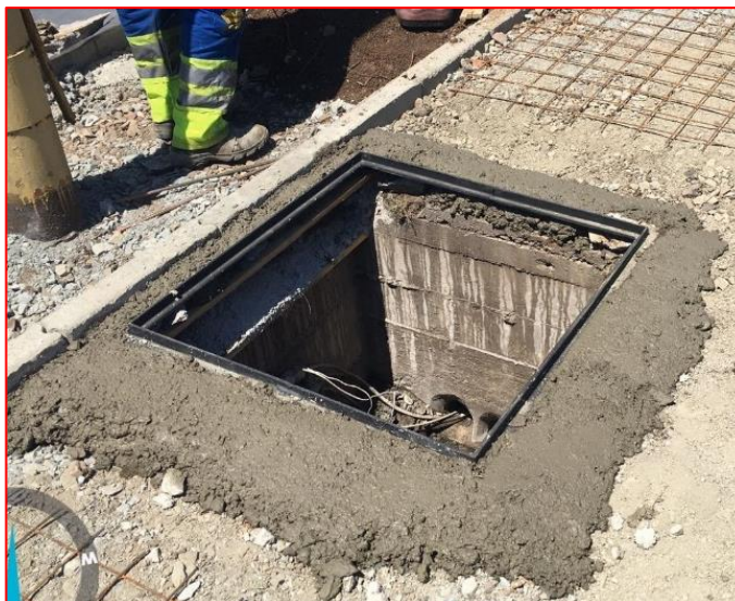
Figura 17 - Adequação de caixas de passagens com assentamento de tampa de FoFo – Fonte: CEASA/PR.
