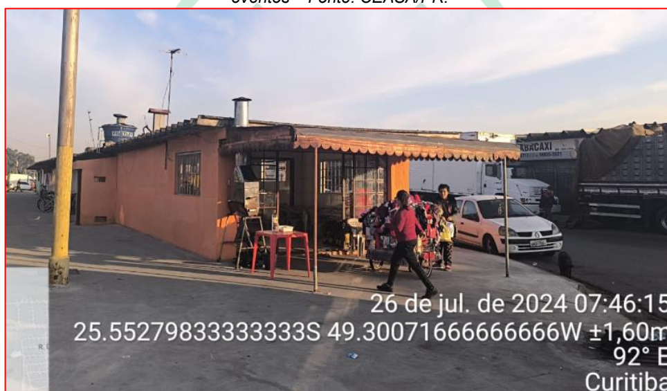
Figura 4 - Edificação do Pavilhão B a ser demolida - Fonte: CEASA/PR.
