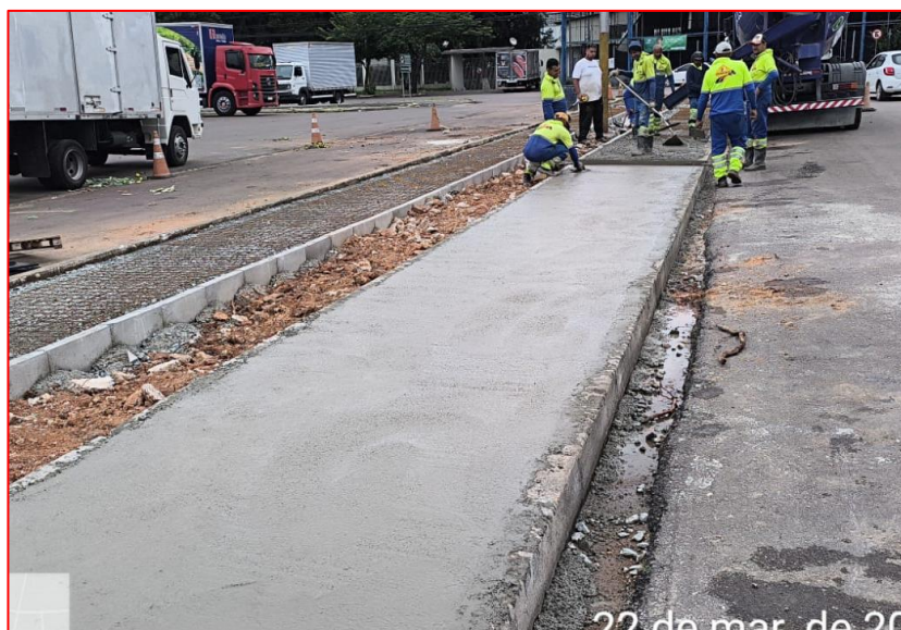
Figura 8 - Colocação de ferragem e posterior concretagem – Fonte: CEASA/PR.
