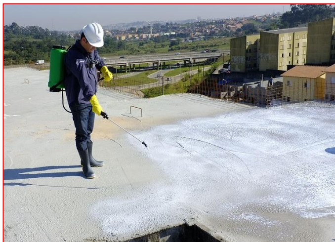
Figura 12 - Aplicação de agente químico para cura do concreto – Fonte: GOOGLE.
