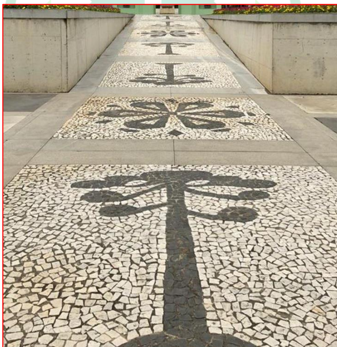
Figura 10 - Exemplo de serviço finalizado de pedra portuguesa com mosaico – Fonte: GOOGLE
