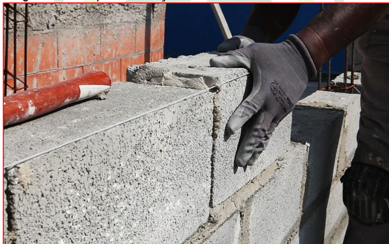
Figura 19 – Exemplo de assentamento de bloco de concreto – Fonte: GOOGLE
