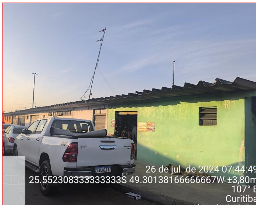
Figura 5 - Edificação do Pavilhão C a ser demolia - Fonte: CEASA/PR.
