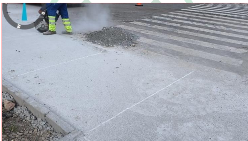
Figura 14 - Execução de juntas serradas – Fonte: CEASA/PR.
