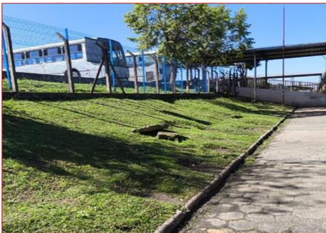
Figura 11 - Local a ser contido com muro de gabião. Pilarete e viga baldrame de concreto a ser demolida. - Fonte: CEASA/PR.
