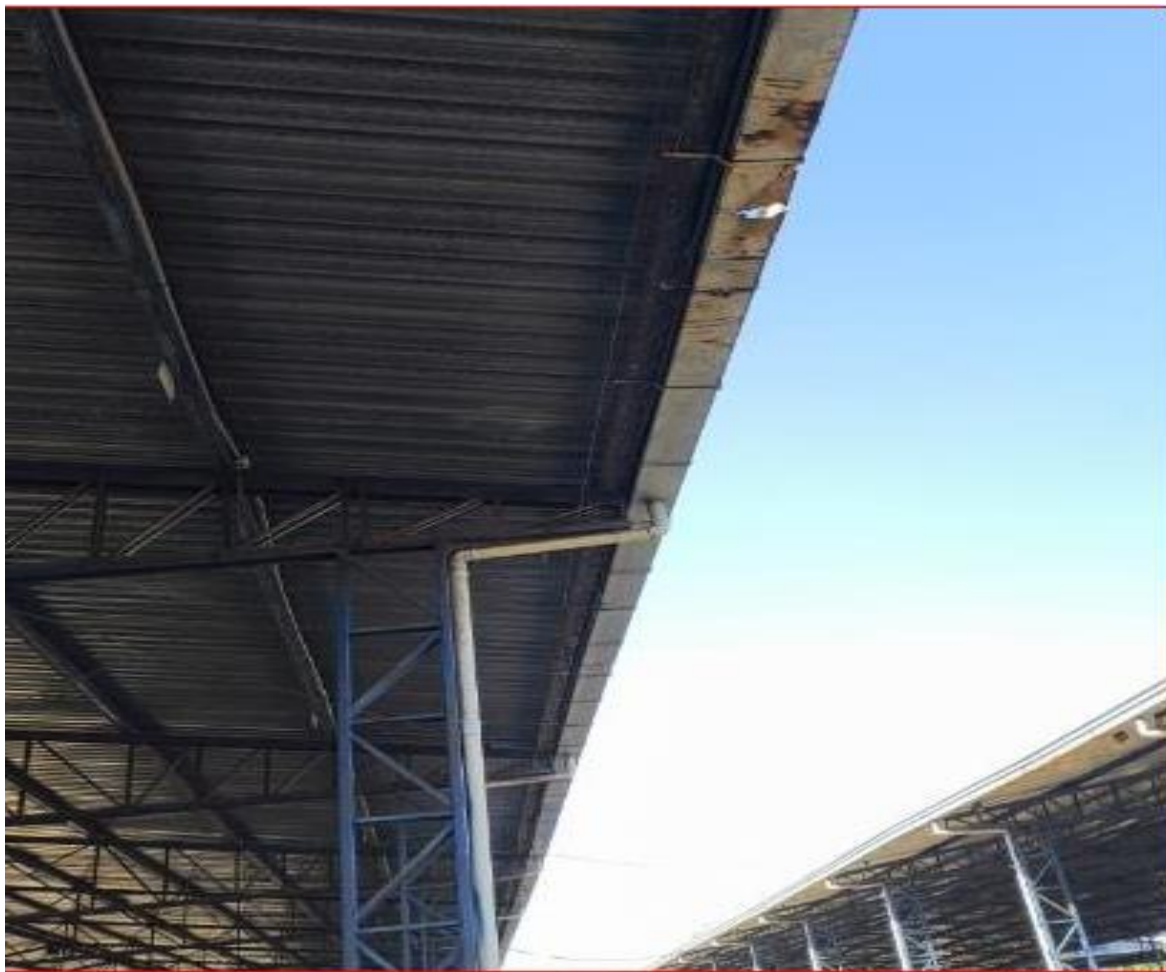
Figura 3 - Algumas das calhas que deverão ser trocadas, conforme quantitativo em planilha orçamentária -Fonte: CEASA/PR
