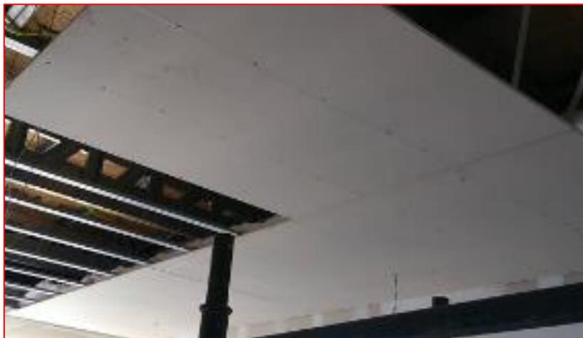
*Figura 26 - Instalação de Forro em Placa cimentícia*
