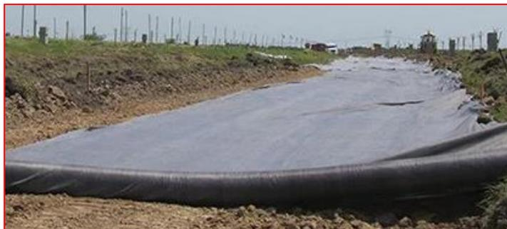
*Figura 46 - Manta geotêxtil para filtragem de água - Fonte: Google*
