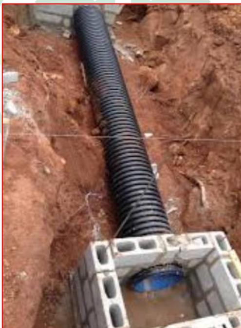
Figura 9 - Tubo PEAD corrugado de parede dupla - Fonte: Google
