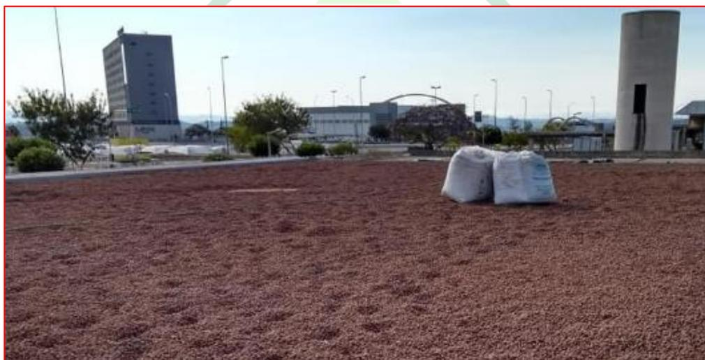
*Figura 47 - Argila expandida em telhado - Fonte: Google*
