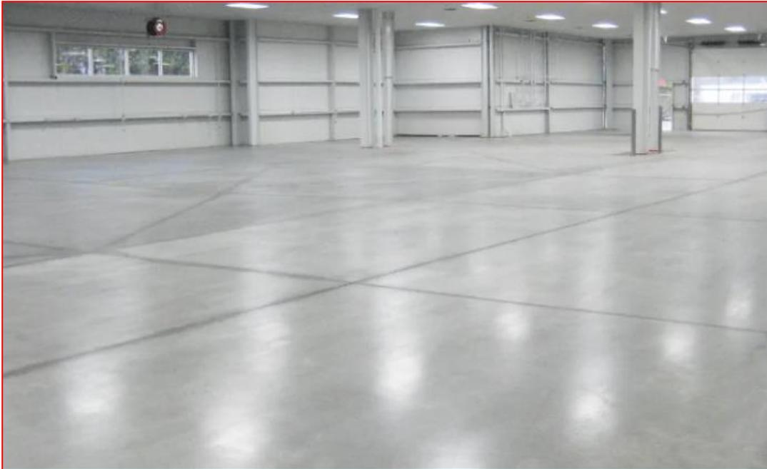
Figura 17 - Acabamento polido em cimento queimado com aplicação de resina - Fonte: Google
