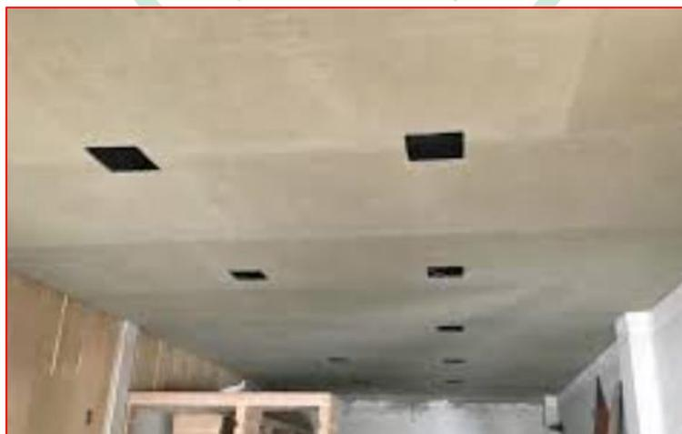
Figura 43 - Especificação final de placa cimentícia instalada - Fonte: Google
