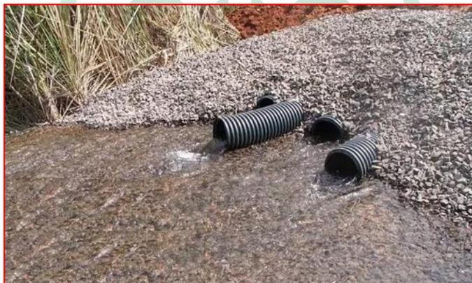
*Figura 45 - Tubo corrugado PEAD para auxílio de drenagem - Fonte: Google*
