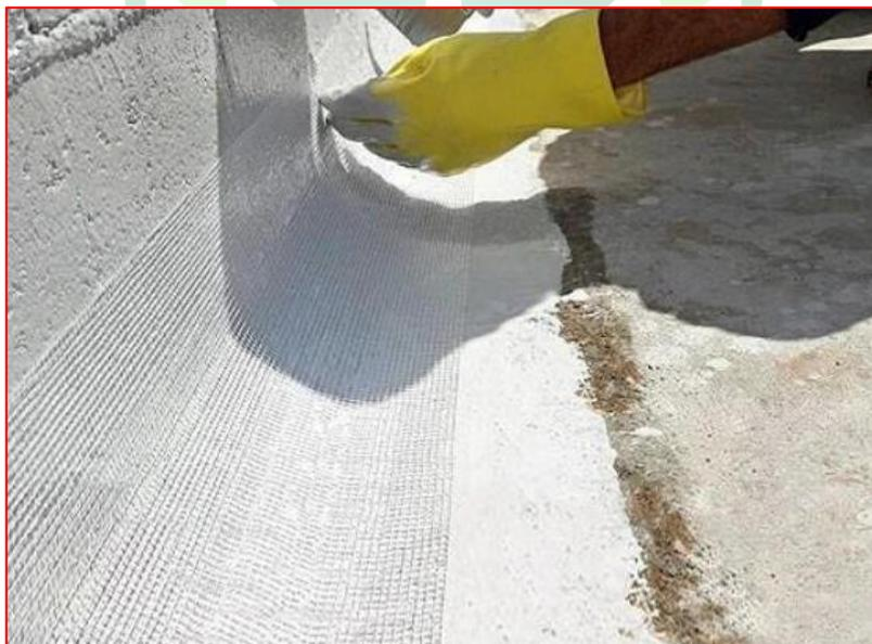
*Figura 25 - Aplicação de impermeabilização flexível - Resina acrílica com véu estruturante - Fonte: Google*
