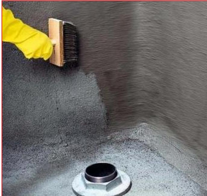
*Figura 24 - Aplicação de impermeabilização semi-flexível - Argamassa Polimérica - Fonte: Google*
