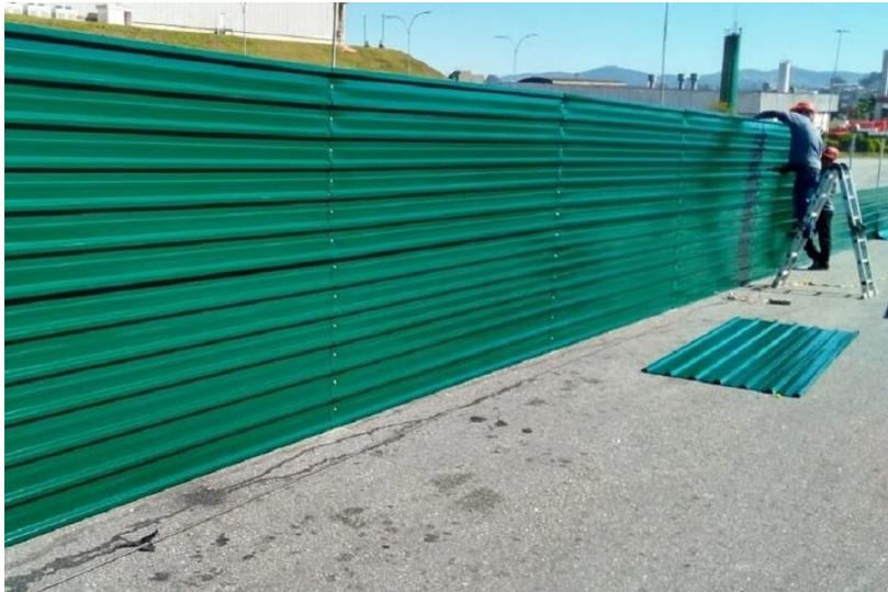
Figura 7 - Tapume em telha metálica trapezoidal - Fonte: Google.
