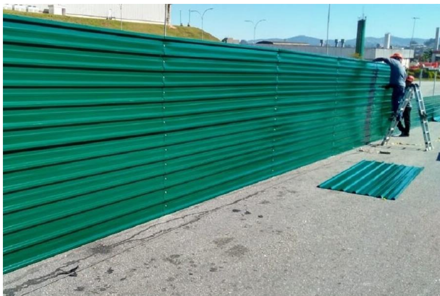
Figura 4 - Tapume em telha metálica trapezoidal - Fonte: Google.
