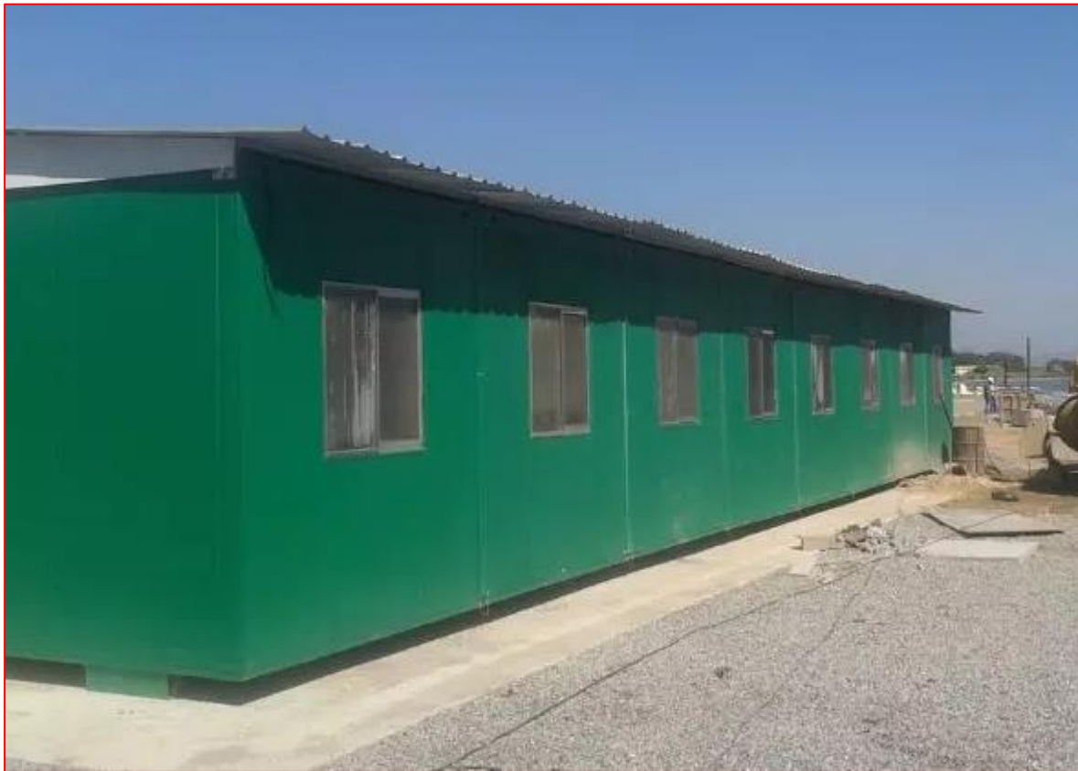
Figura 1 - Canteiro de obras em container - Fonte: Google
