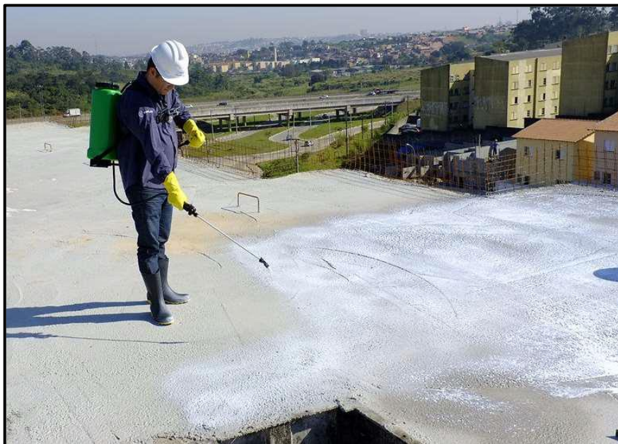
Figura 15 - Aplicação de agente químico para cura do concreto
