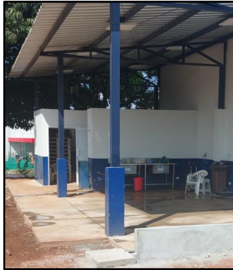
Figura 20 - Proteção em concreto armado para pilares metálicos
