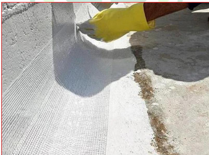
Figura 26 - Aplicação de impermeabilização flexível - Resina acrílica com véu estruturante - Fonte: Google
