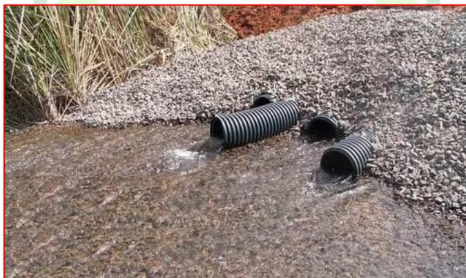
Figura 46 - Tubo corrugado PEAD para auxílio de drenagem - Fonte: Google
