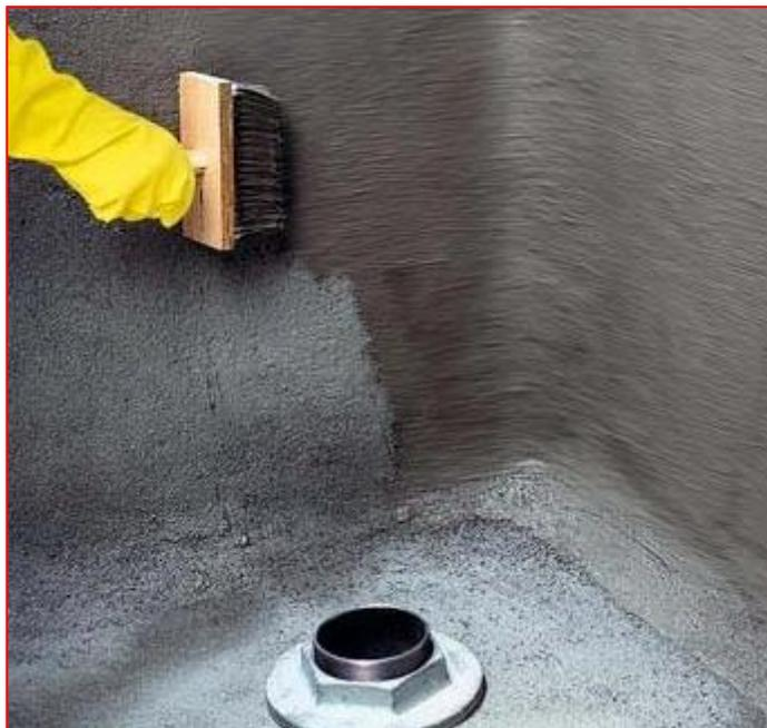
Figura 95 - Aplicação de impermeabilização semi-flexível - Argamassa Polimérica - Fonte: Google
