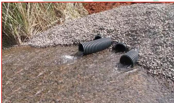
*Figura 116 - Tubo corrugado PEAD para auxílio de drenagem - Fonte: Google*
