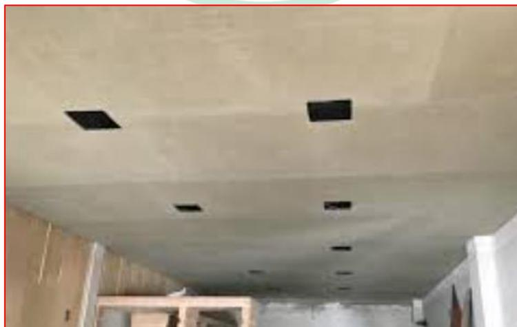
Figura 44 - Especificação final de placa cimentícia instalada - Fonte: Google
