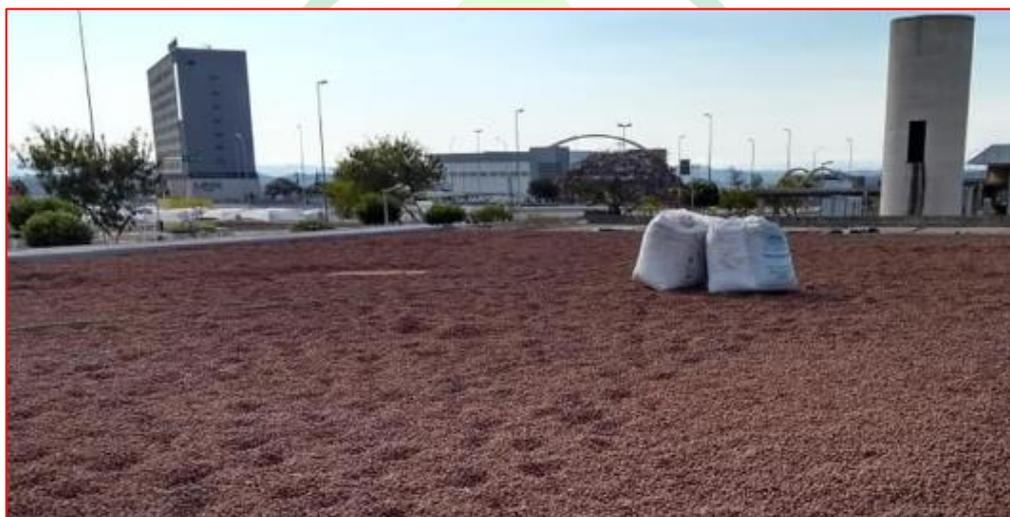
Figura 48 - Argila expandida em telhado - Fonte: Google
