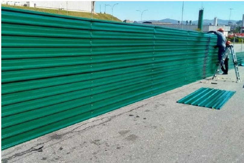
Figura 82 - Tapume em telha metálica trapezoidal - Fonte: Google.
