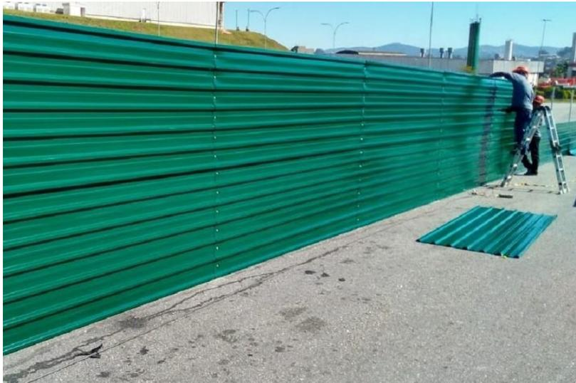
*Figura 12 - Tapume em telha metálica trapezoidal - Fonte: Google.*
