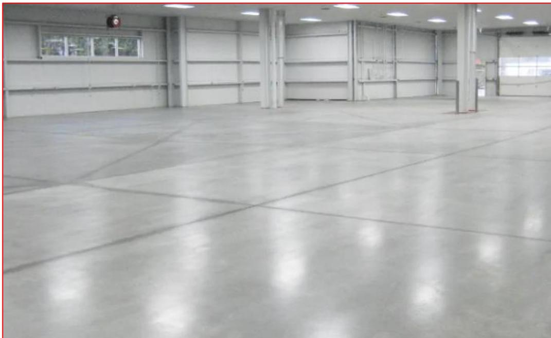
Figura 90 - Acabamento polido em cimento queimado com aplicação de resina - Fonte: Google
