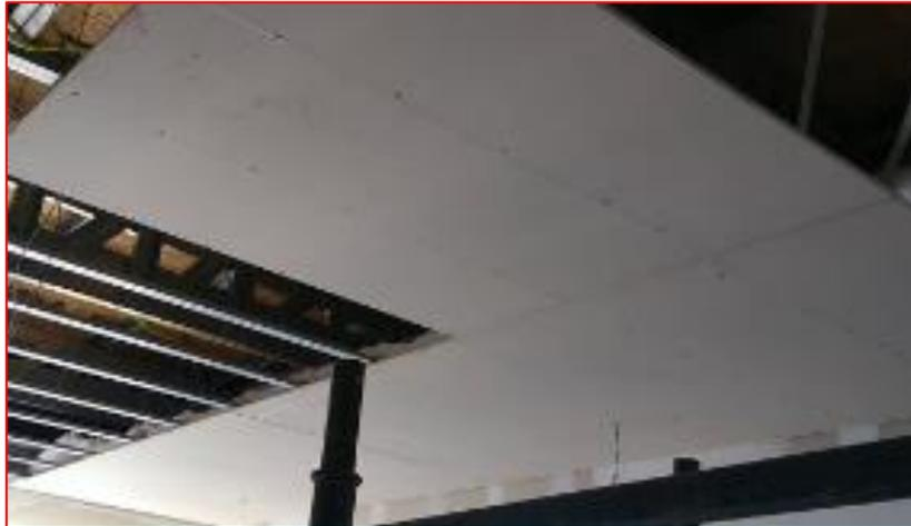
*Figura 27 - Instalação de Forro em Placa cimentícia*
