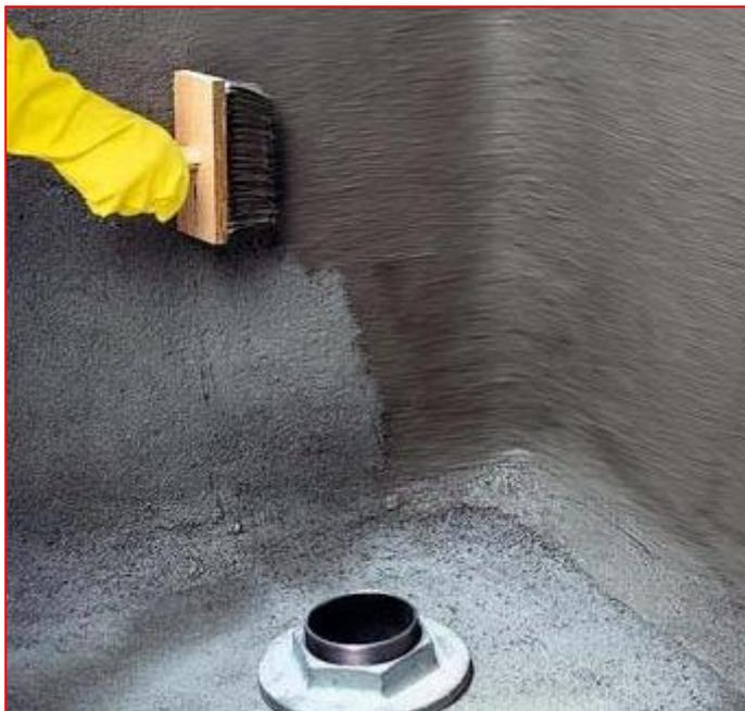
Figura 25 - Aplicação de impermeabilização semi-flexível - Argamassa Polimérica - Fonte: Google
