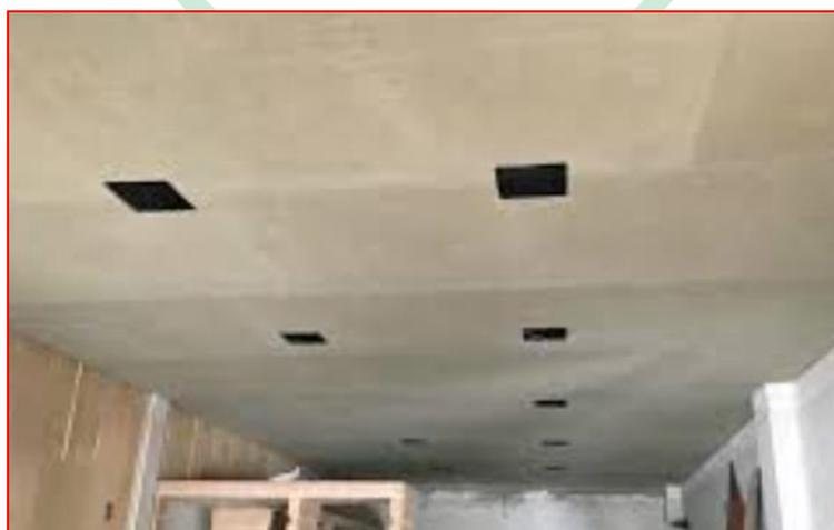
Figura 114 - Especificação final de placa cimentícia instalada - Fonte: Google
