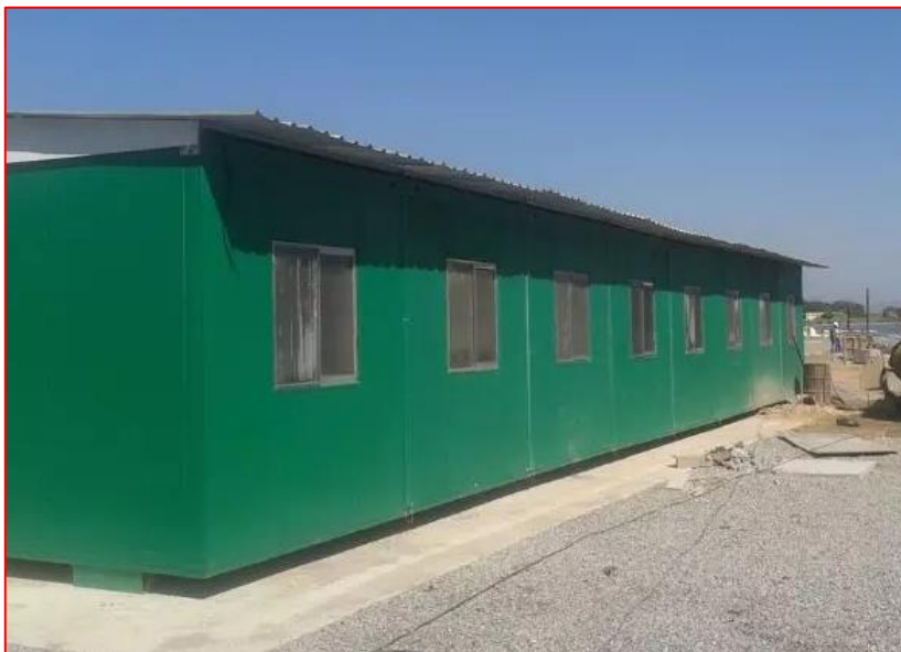
Figura 2 - Canteiro de obras em container - Fonte: Google
