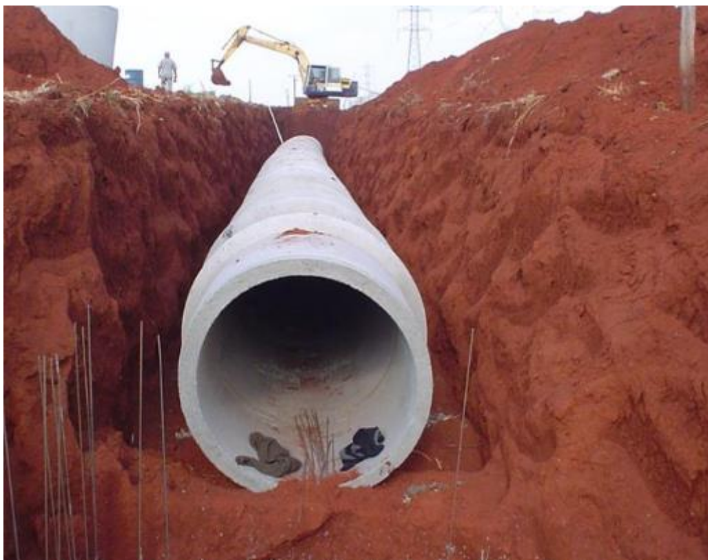
Figura 5 - Instalação de tubo de drenagem
