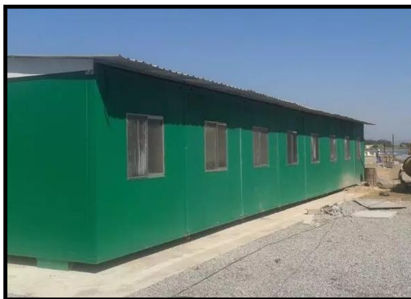
Figura 1 - Canteiro de obras em container - Fonte: Google
