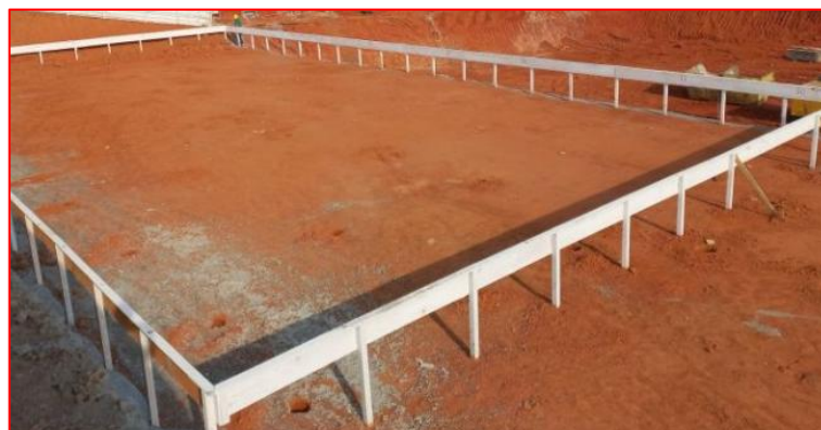
Figura 3 - Gabarito de obra - Fonte: Google
