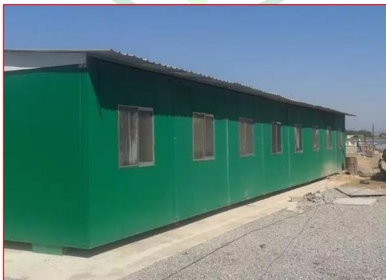
Figura 1 - Canteiro de obras em container - Fonte: Google
