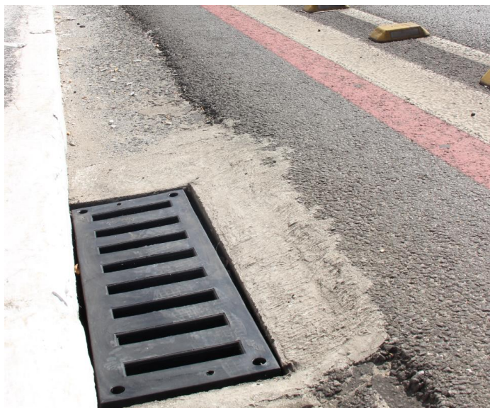
Figura 7 - Caixa coletora de sarjeta com grelha de ferro fundido
