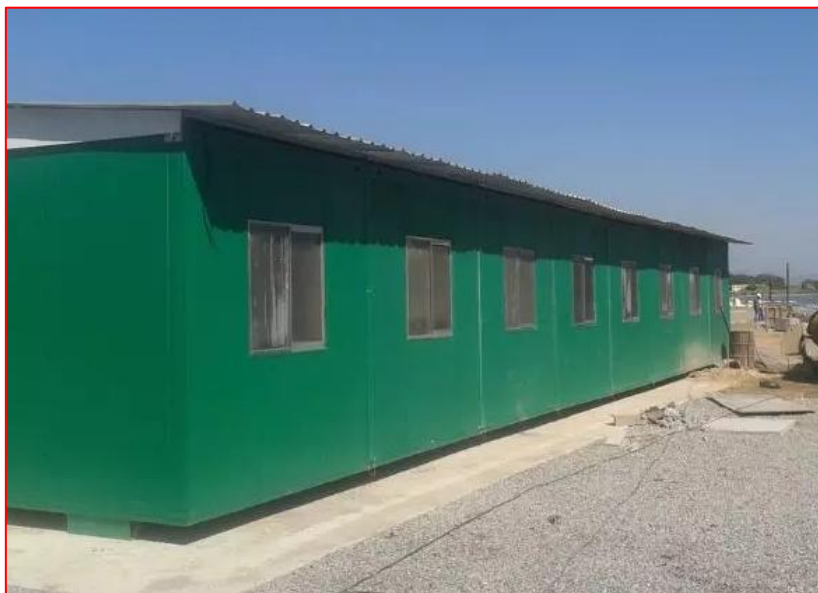
Figura 1 - Canteiro de obras em container - Fonte: Google
